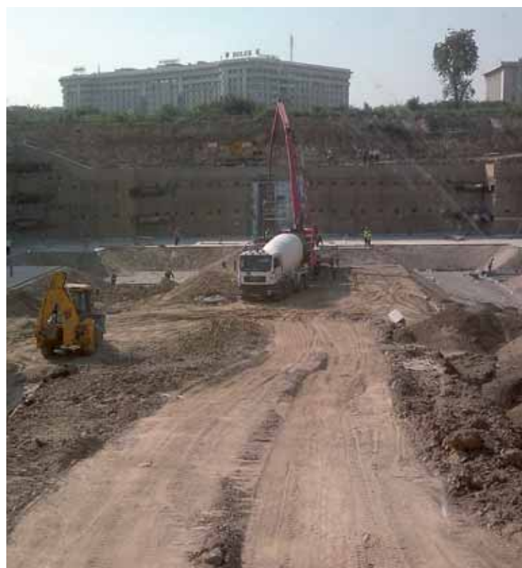
National Cathedral. Mobiles Betonwerk für den Bau der geplanten Kathedrale.
