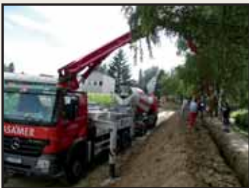
Hochwasserschutz- wand St. Valentin
