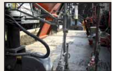
Gleitschalungsfertiger für zweischichtigen Einbau
