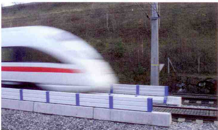
Das Siegerprojekt - eine niedrige Lärmschutzwand für Eisenbahngleise
